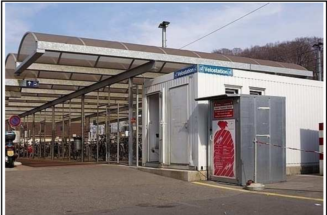
Velostation am Bahnhof Olten (Quelle: www.velostation.ch/velostationen/olten/ )
