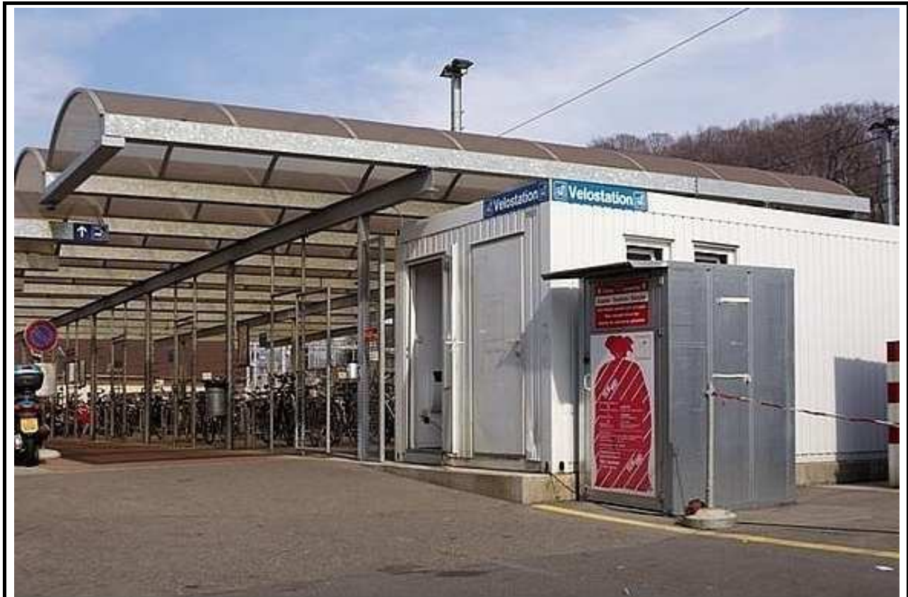
Velostation am Bahnhof Olten (Quelle: www.velostation.ch/velostationen/olten/ )
