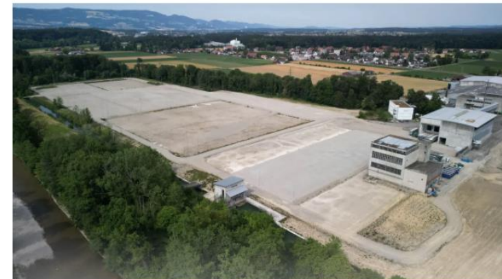
Auf dem Areal der ehemaligen Papierfabrik Utzenstorf ist ein Logistikhub für Digitec Galaxus geplant.
