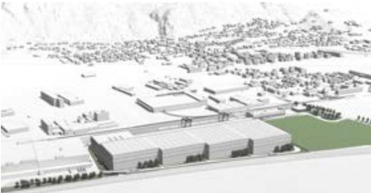
*Richtprojekt, Stand Januar 2025, Visualisierung 1: Der Neubau von Südwesten gesehen mit Egerkingen im Hintergrund. Links im Bild das blaue Bestandesgebäude «LCO», welches umgenutzt, integriert und mit dem Neubau verbunden wird. Die südliche Fassade des Neubaus ist entlang der A1 abgestuft. Im Osten verbleiben ca. 5.5 ha Landwirtschaftsfläche, die nicht eingezont werden. Bildquelle: MVB.*
